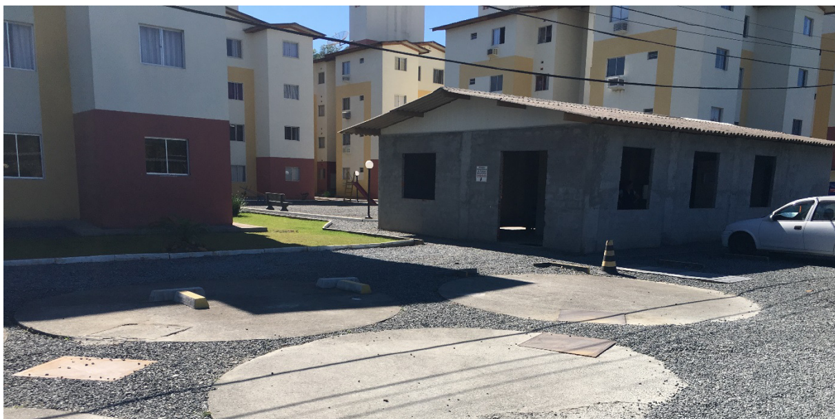
Foto 06 – Vista da central de condomínio semi-acabada – Fonte CPL
