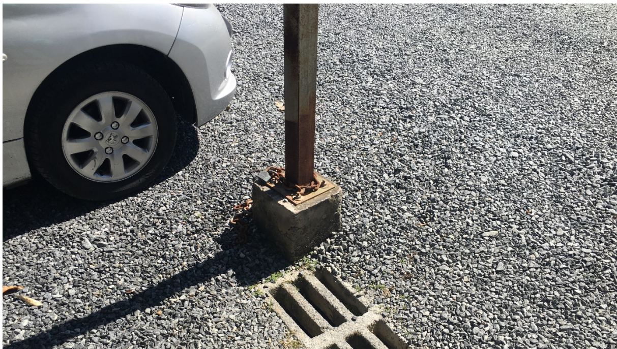
Foto 02 – Vista da Fundação superficial – Fonte CPL
