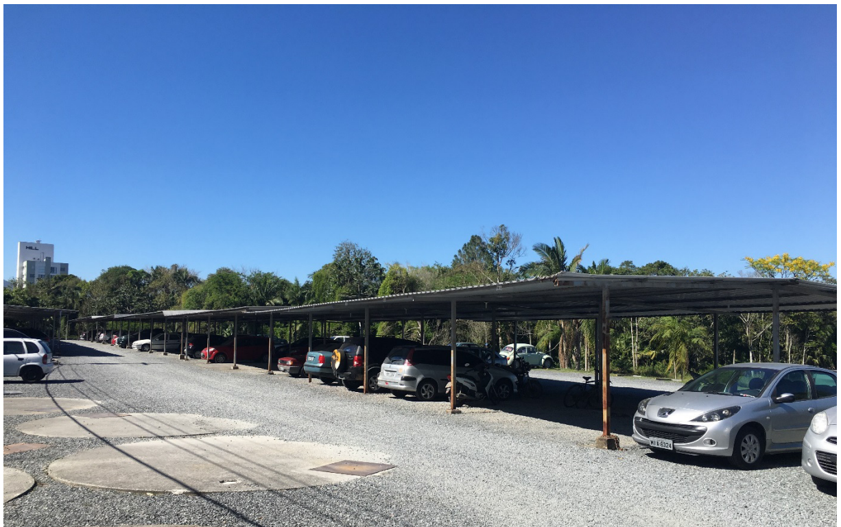
Foto 01 – Vista da estrutura metálica – Fonte CPL
