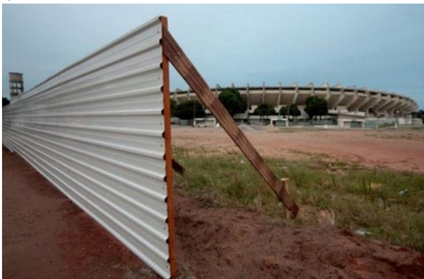
Tapume com fechamento metálico.
