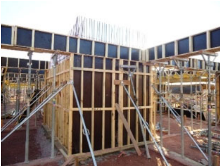
Forma para estrutura de concreto em chapa de madeira compensada plastificada.
