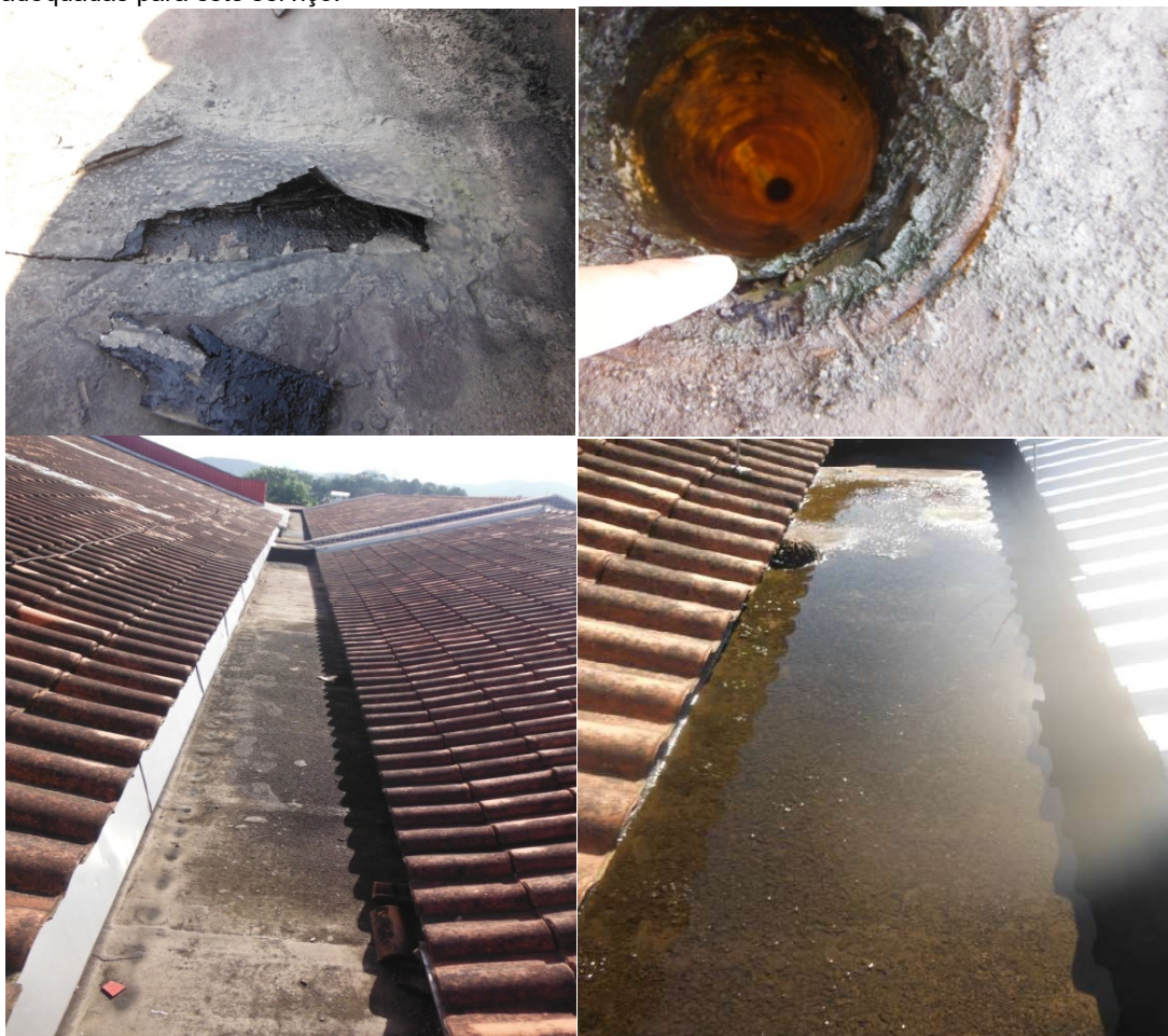
Fotos: Manta asfáltica deteriorada a ser removida.
