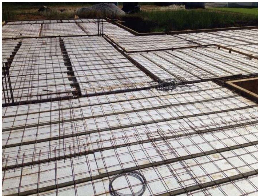
Ilustração de colocação de tela soldada sobre lajes.
