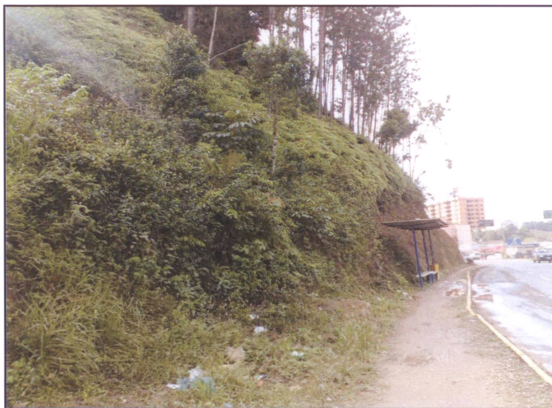
Foto 1 – Situação da encosta na seção que não sofreu deslizamento.
