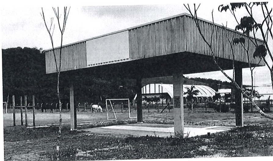
Imagem 06: Platibanda a ser removida e pintada.
