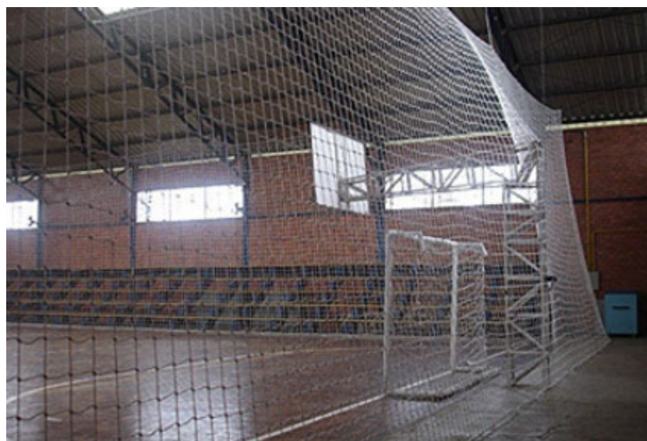
Exemplo de instalação da rede de proteção no ginásio de esportes.
