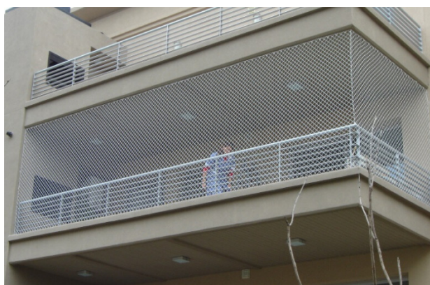
Exemplo de instalação da rede de proteção na parede da biblioteca.
