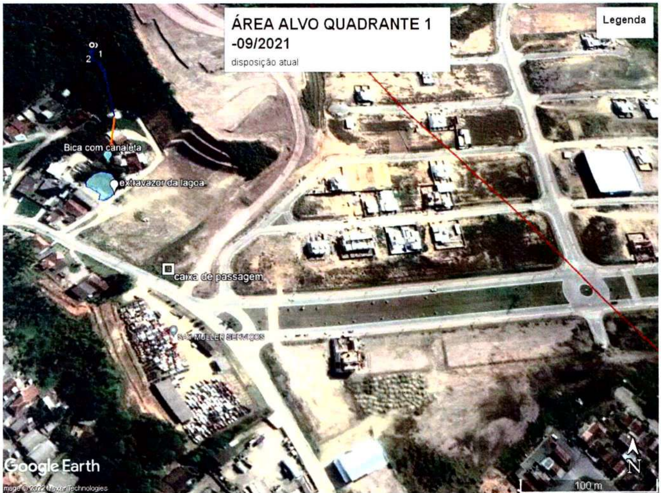
Figura 9 - Último imageamento disponível pela plataforma Google Earth Pro para o quadrante em questão. Na imagem, está disposto as estruturas que, ao que tudo indica, tem ligação com a tubulação do curso hídrico, sendo elas o desemboque das massas d'água que extravasam da lagoa [ 22J 702813.80 m E/7018232.02 m S] e caixa de passagem [22J 702869.00 m E/7018155.00 m S].
