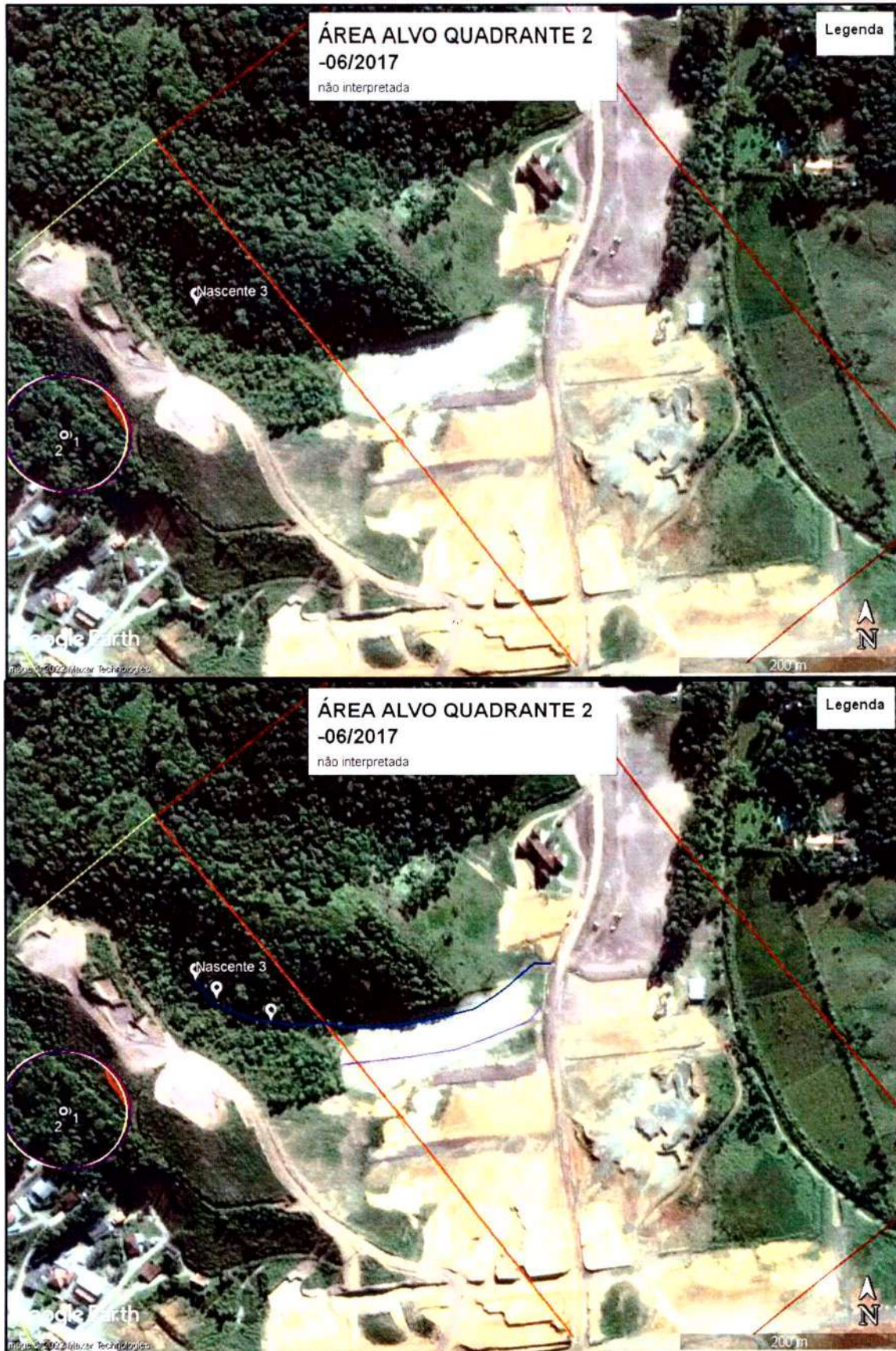
Figura 20 - Imageamentos para o ano de 2017. Possível perceber que fora alocado o curso hídrico para a encosta da topografia, em disposição claramente diversa de todos os talvegues drenantes que já se dispuseram no decorrer dos anos.
