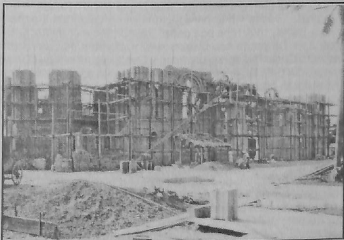
Obras de construção em 1945
